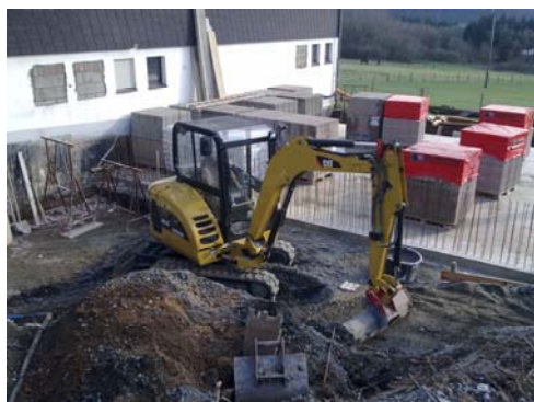
Der Umbau hat begonnen
